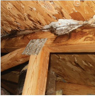
Cernes d'humidité dans un entretoit
