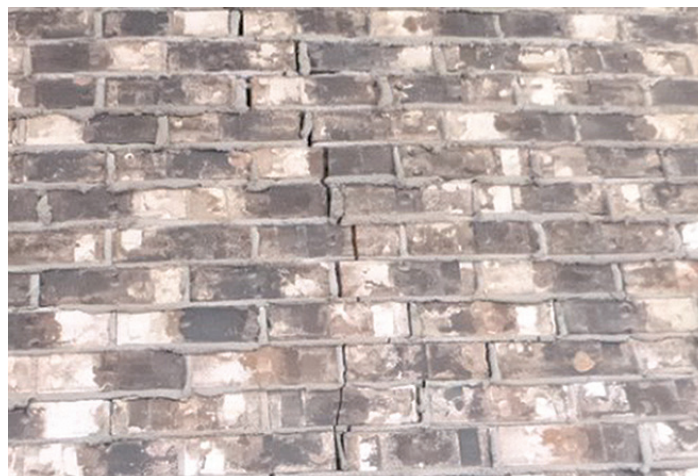
Parement/mortier fissuré
