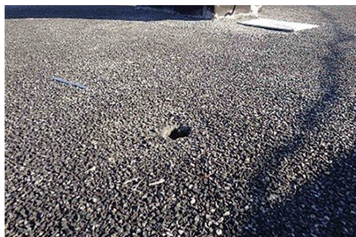
Drain de toit sans grille
