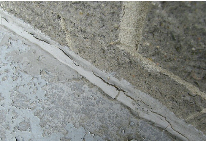
Calfeutrage fissuré/desséché
