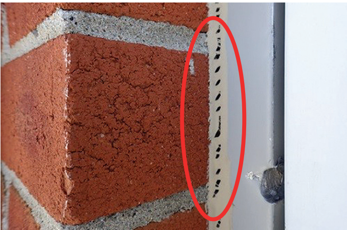
Calfeutrage fissuré/desséché
