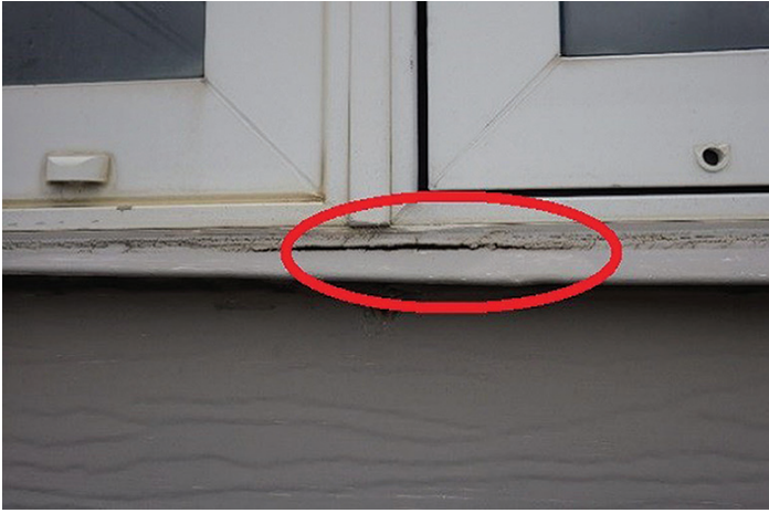
Calfeutrage fissuré/desséché
