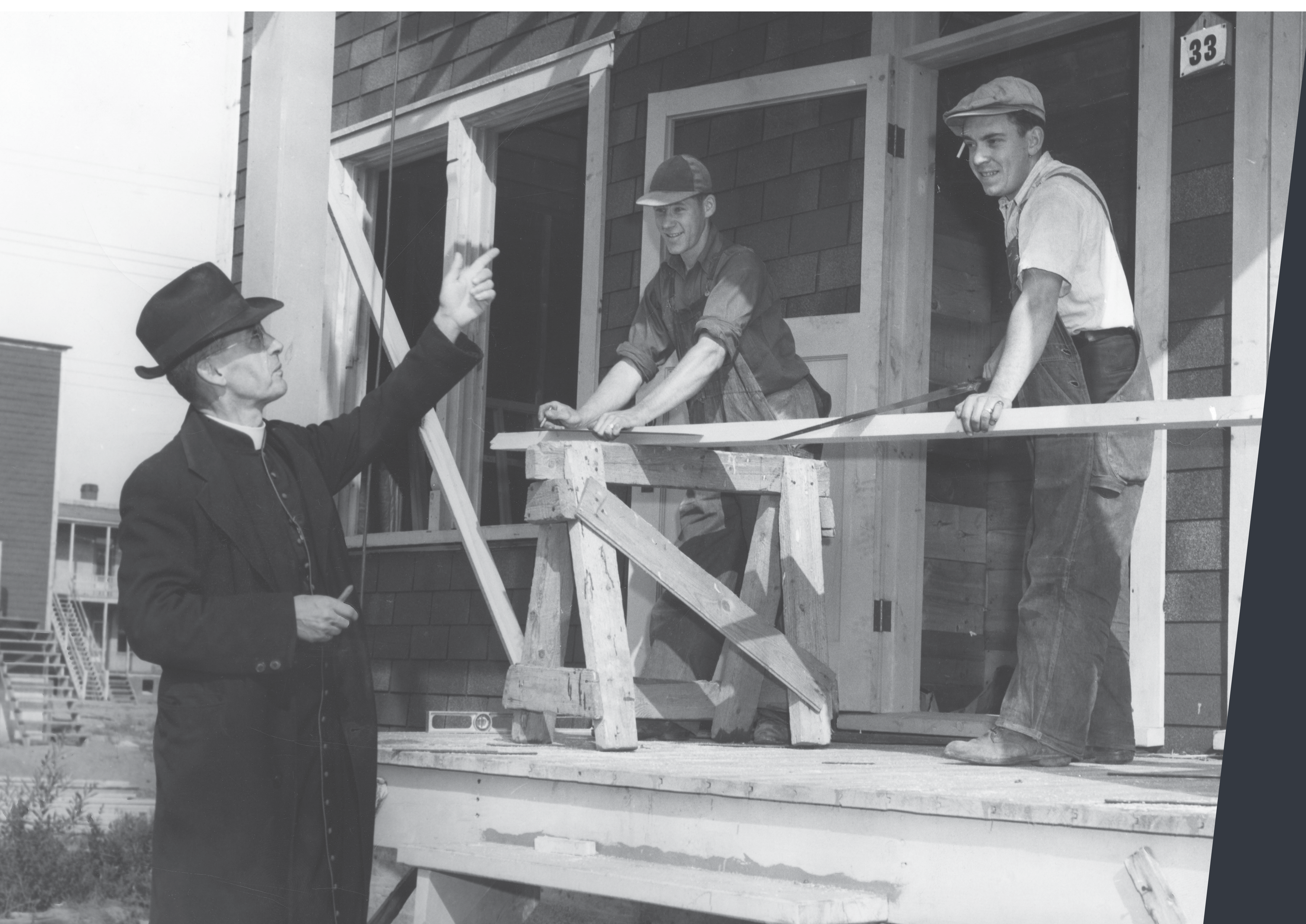
Le chanoine Chamberland sur les chantiers de la Coopérative d'habitation Sainte-Marguerite de Trois-Rivières. Vers 1944. Source : BAnQ, Centre d'archives de Québec, Fonds Conseil de la coopération du Québec
